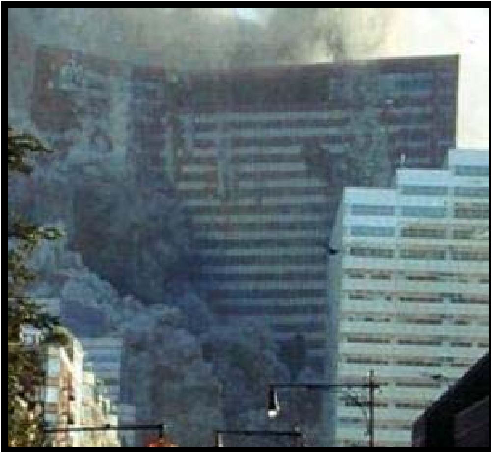
Le bâtiment 7 du World Trade Center (ou WTC 7) composé de 49 étages (226 m) s'est effondré à la vitesse de la chute libre (démolition contrôlée) et ce... sans avoir subi le moindre impact d'avion... le 11 Septembre 2001 !
